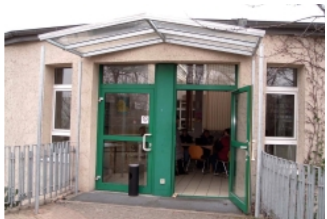
Das neue Vordach
